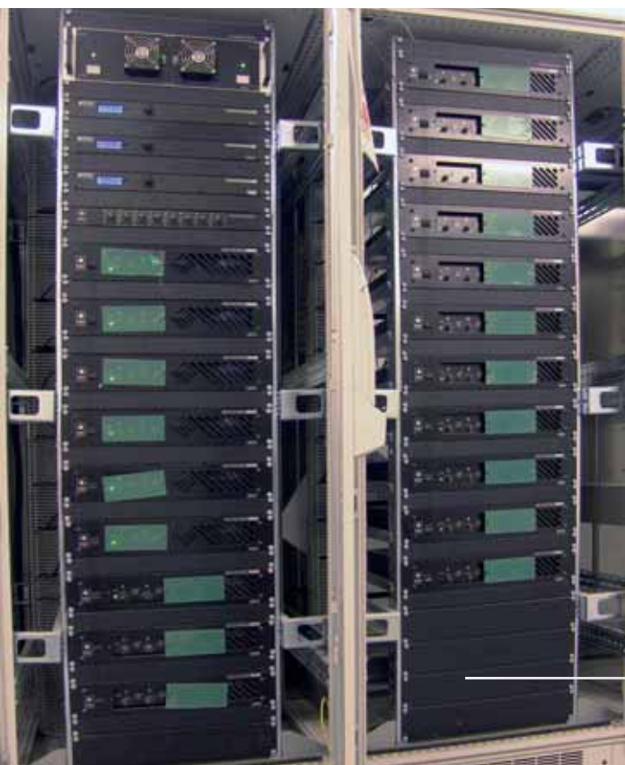
Einer der zahlreichen Gestellschränke mit Spider 44 und Leistungsendstufen, rechts drei Spider 44, darunter die im Text erwähnten Pegelsteller
