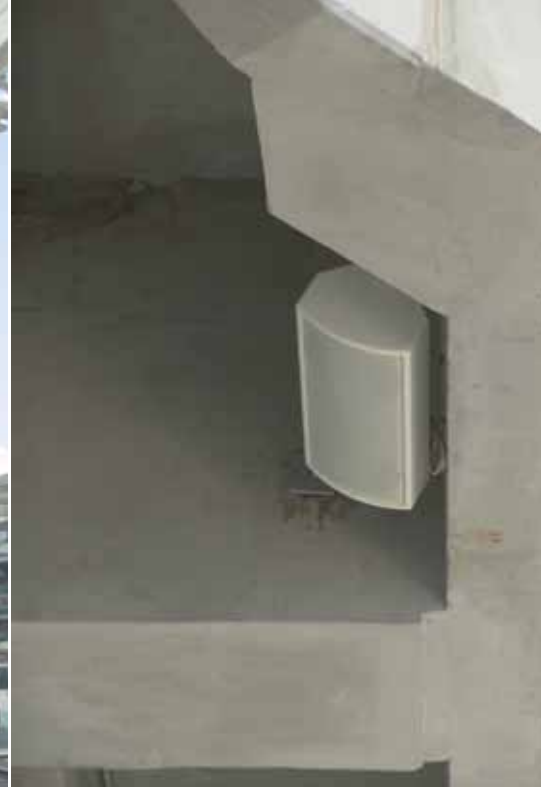
Sitzbereiche der VIP-Logen (links) mit unter den Balkonen installierten Delaylautsprechern, die ähnlich auch im Boxengebäude (Seite 9, oben) installiert sind.
