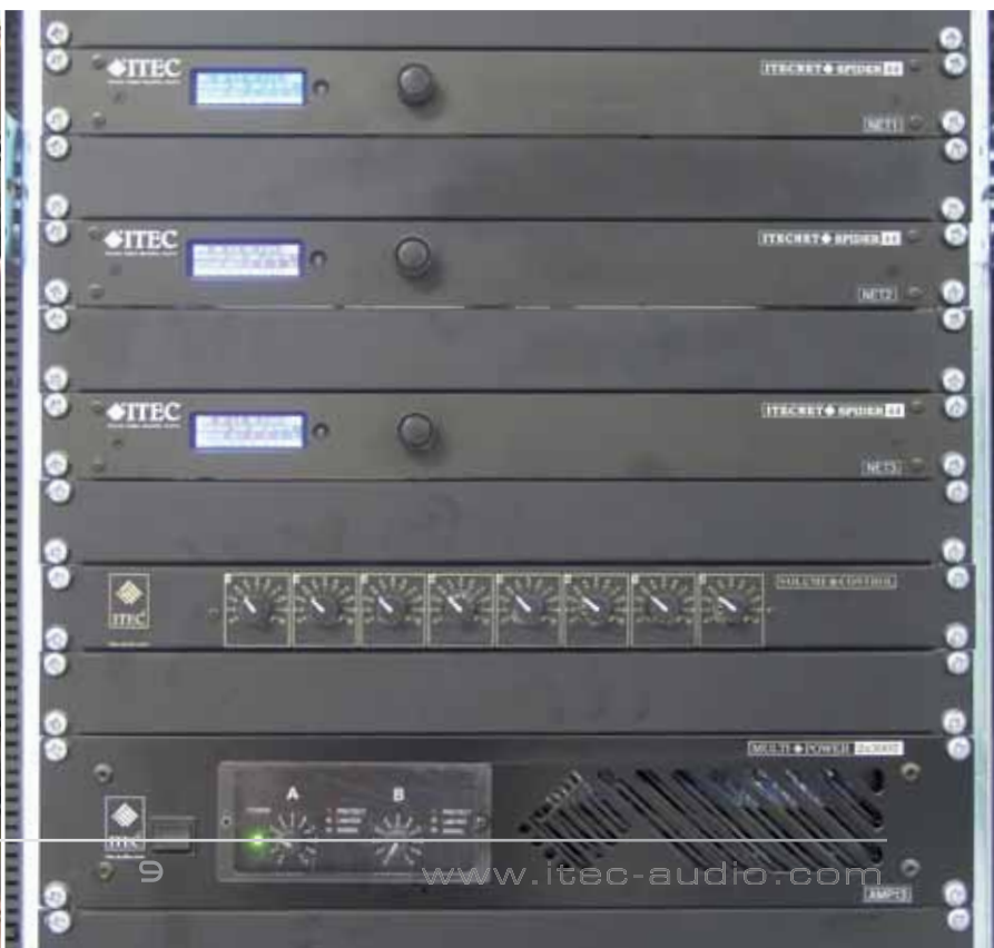
Einer der zahlreichen Gestellschränke mit Spider 44 und Leistungsendstufen, rechts drei Spider 44, darunter die im Text erwähnten Pegelsteller
