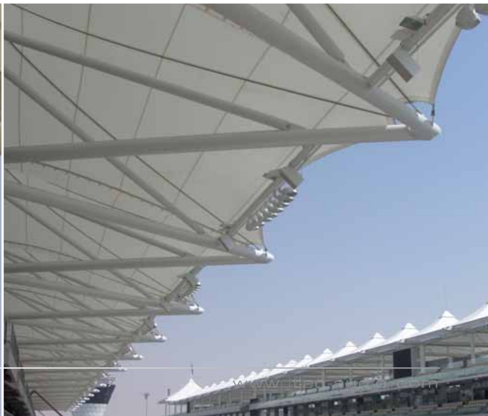
Tribünenenddach mit zahlreichen, von der Dachvorderkante geflogenen Lautsprechersystemen
